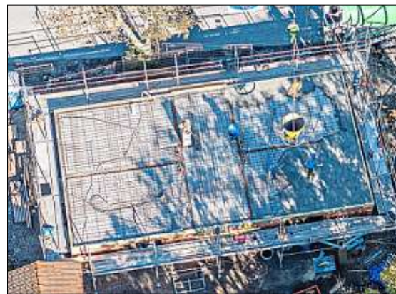
An der Hohenwarter Straße entstehen Wohnungen für Firmenmitarbeiter.
