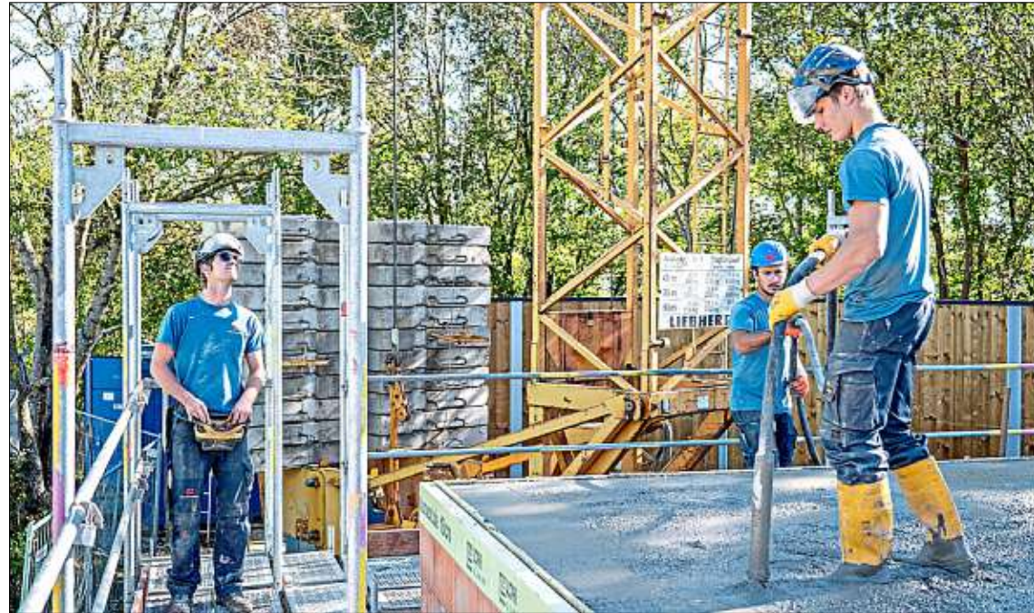
Selbstständig betonieren die jungen Mitarbeiter die Decke.
