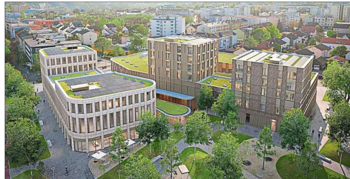
Das Burghauser Unternehmen Hinterschwepfinger realisiert für die „meine Volksbank-Raiffeisenbank“ eG das neue Salzachzentrum mit einer nachhaltigen Mischbebauung aus Wohnen, Büros, Nahversorgung und Gastronomie.
