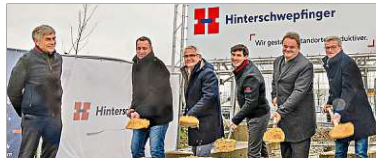
Beim Spatenstich (von links): Josef Hinterschwepfinger (Geschäftsführer Hinterschwepfinger), Reinhard Feilmeier (2. Bürgermeister Iggsbach), Stefan Gigl (Karl Bau), Niclas Schwinke (Projektmanager Hinterschwepfinger), Peter Schmidt (Regierung von Niederbayern) und Landrat Bernd Sibley. – F.: Fenecon
