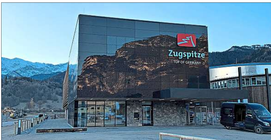
Die Fassade wird von schwarz emalliertem Glas und Holzlamellen geprägt. Im Glas spiegeln sich je nach Betrachtungswinkel Himmel und Berge, wodurch ein Gefühl der Transparenz entsteht.
