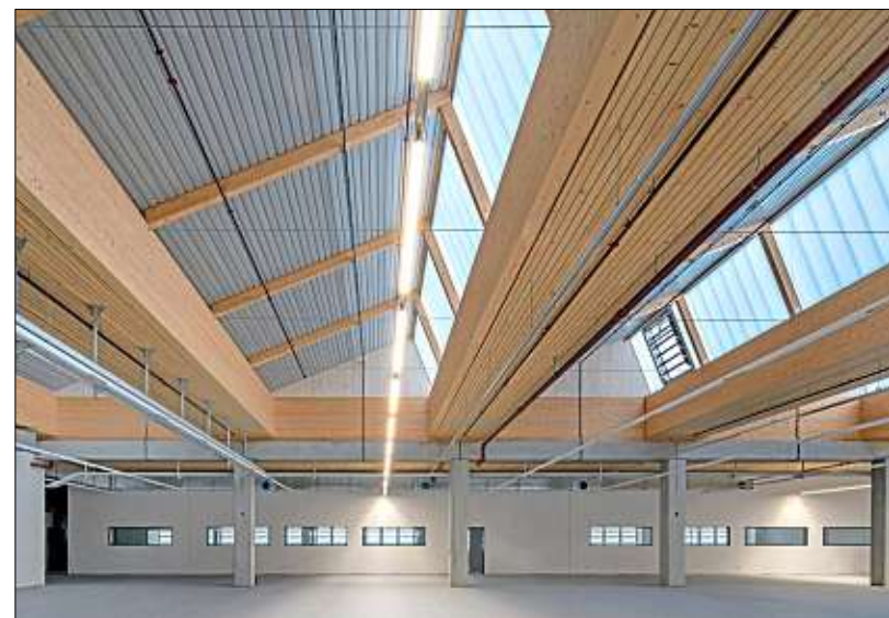
Bis zu 27 Meter lassen sich beispielsweise mit dem Kielsteg-System direkt als Einfeldsystem überbauen. – Foto: hw
