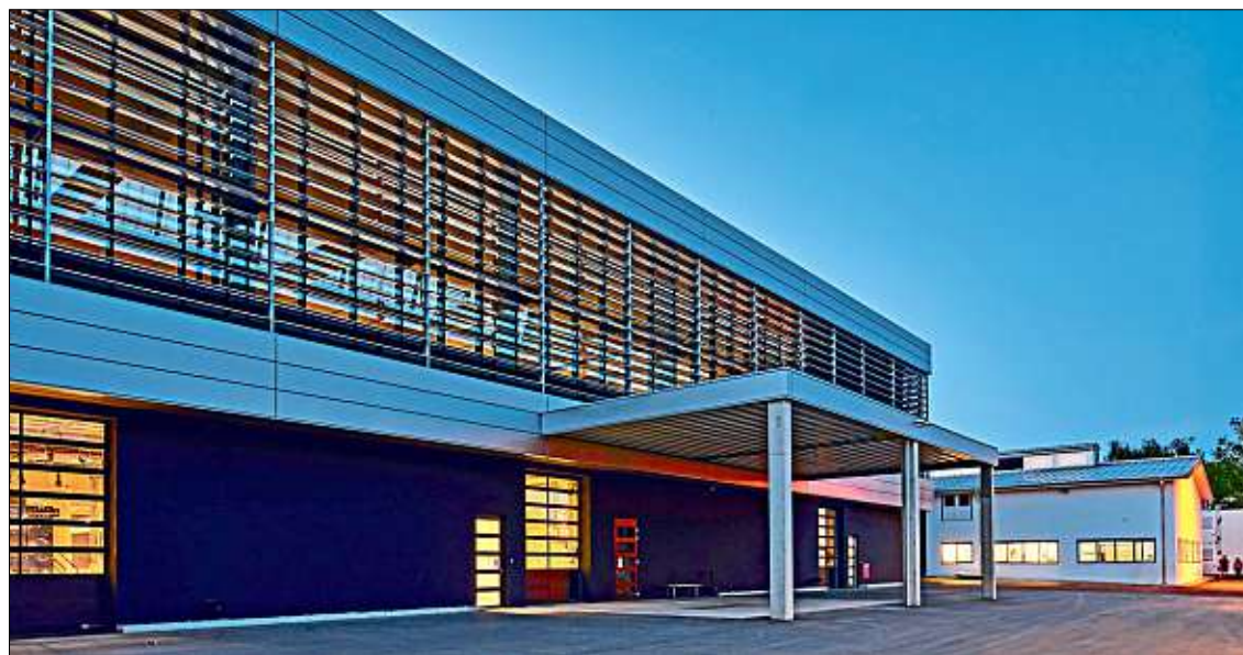
Das neue Produktionszentrum für Oberflächentechnik bei Rosenberger in Fridolfing: Durch eine zweigeschossige Bauweise mit aufgeständerten Produktionsanlagen konnte der Flächenbedarf deutlich reduziert werden.
