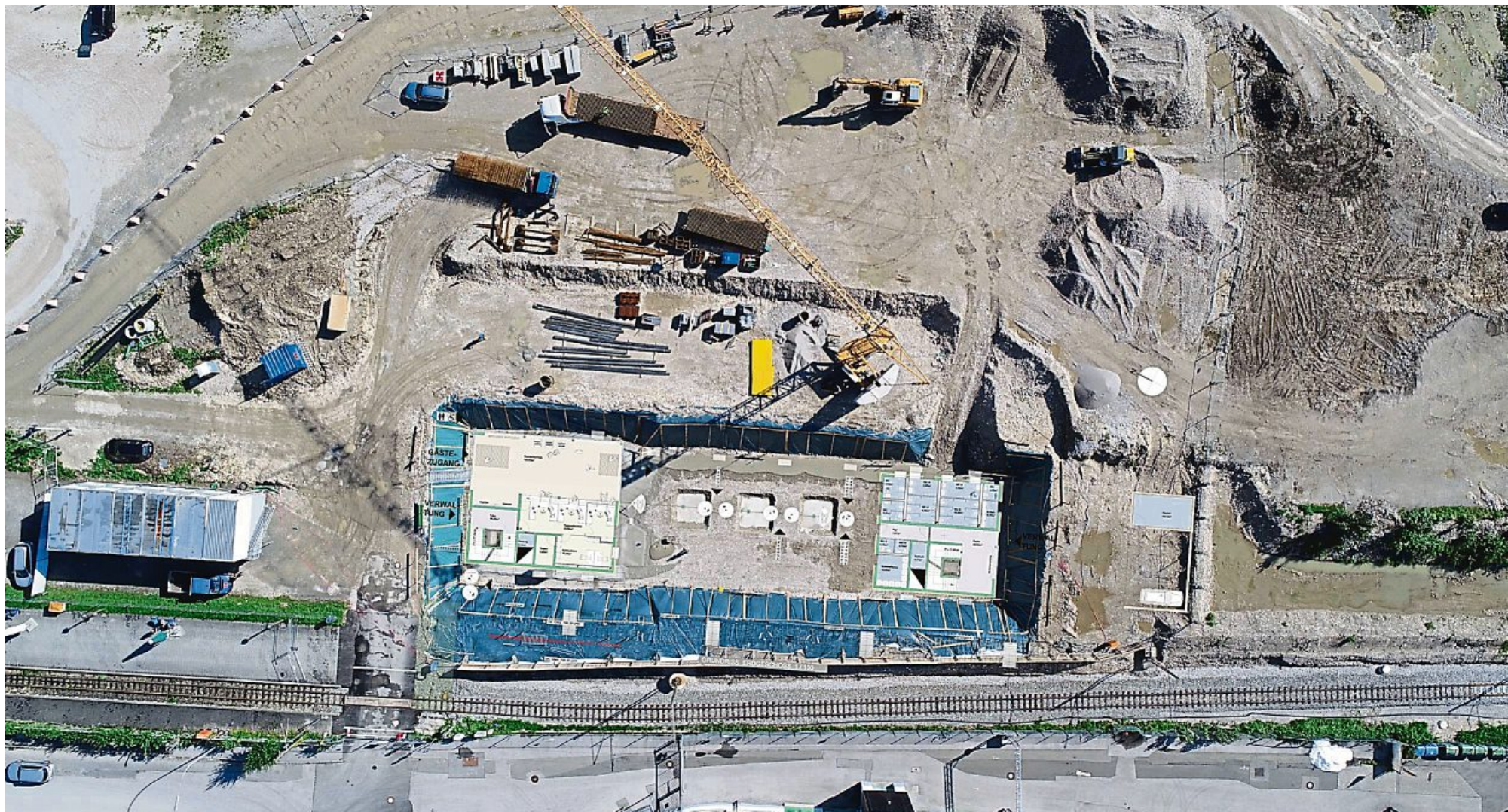
Vogelperspektive: ein Luftbild der Fläche an der Olympiastraße, wo derzeit der neue Zugspitzbahnhof entsteht.
